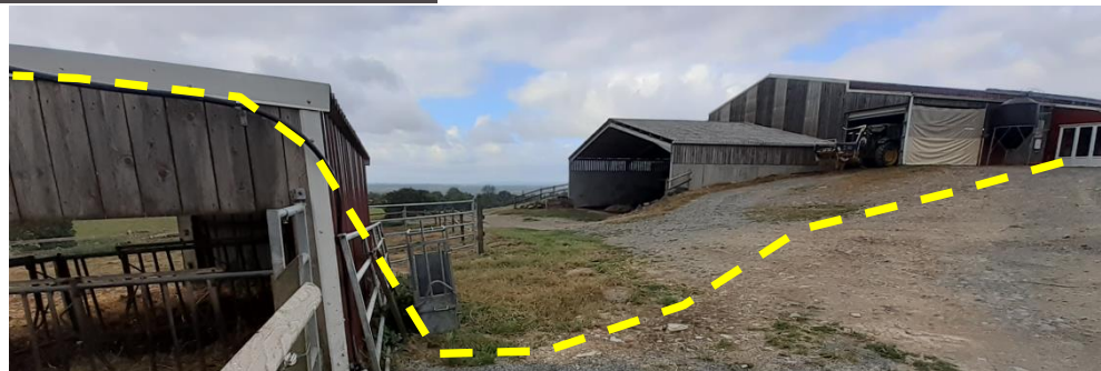
Abreuvement au milkbar via pompe depuis la laiterie (50m)
