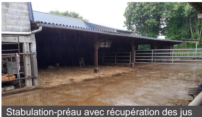
Stabulation-préau avec récupération des jus
